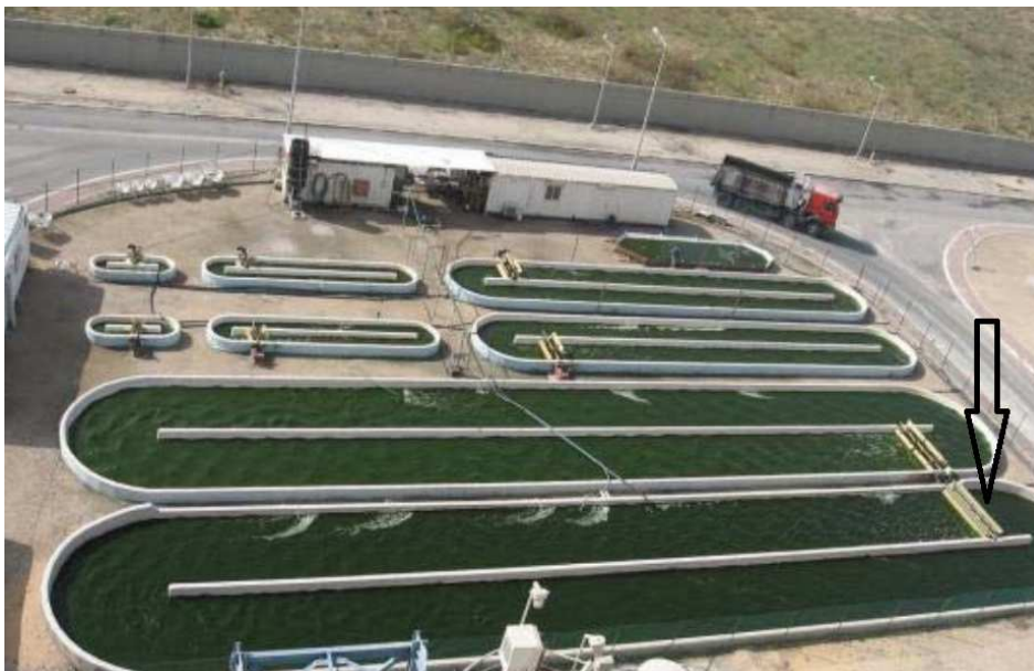
Figura 2. Tanques individuais de raceway pond . Observar pás de agitação. Fonte: (7).
