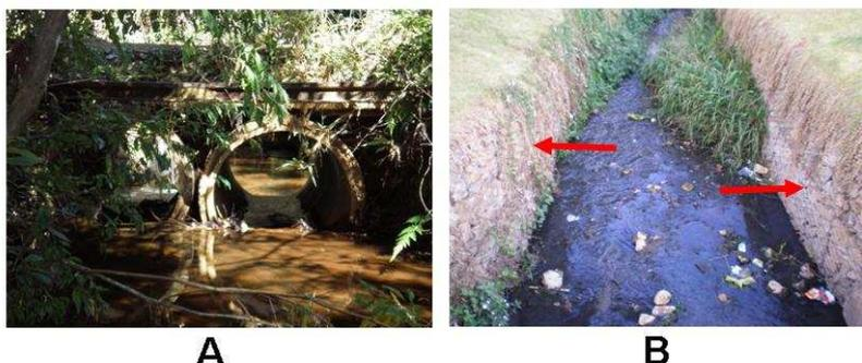
**Figura 9** - Diferentes alterações no canal de dois trechos de rios. Em (A) observa-se uma situação encontrada no PEIT onde nota-se a presença de manilha para vazão sob a estrada. Em (B) observa-se a retificação de um curso d'água na zona urbana de Ouro Preto - MG, onde nota-se a presença de gabiões nas laterais das margens (indicados pelas setas).
